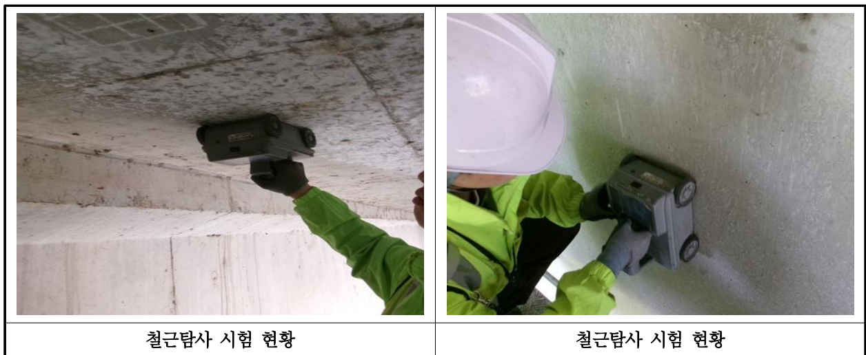
【사진 1.4.2】 철근탐사 시험
