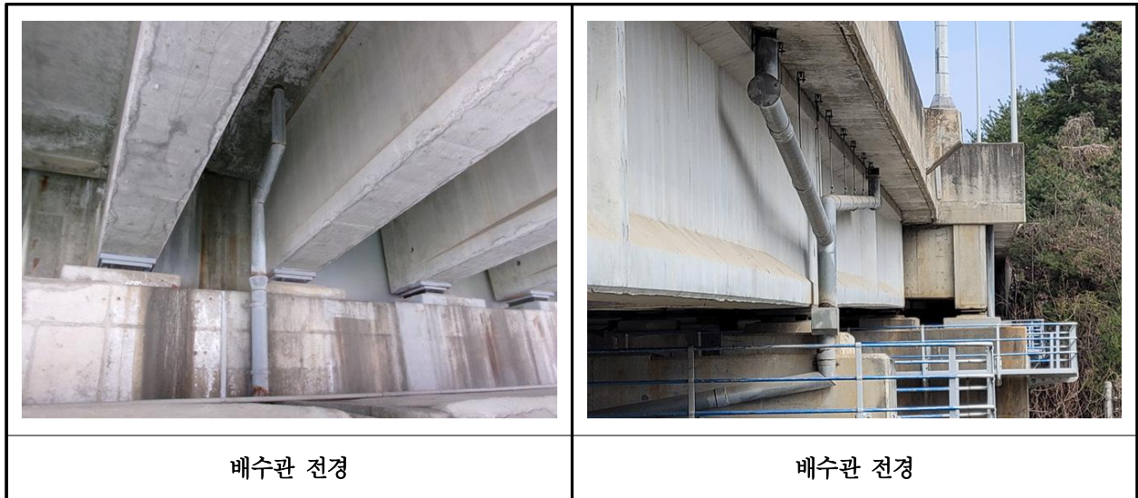
【사진 1.3.19】 배수시설 전경
