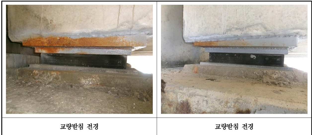
【사진 1.3.12】 교량받침 전경
