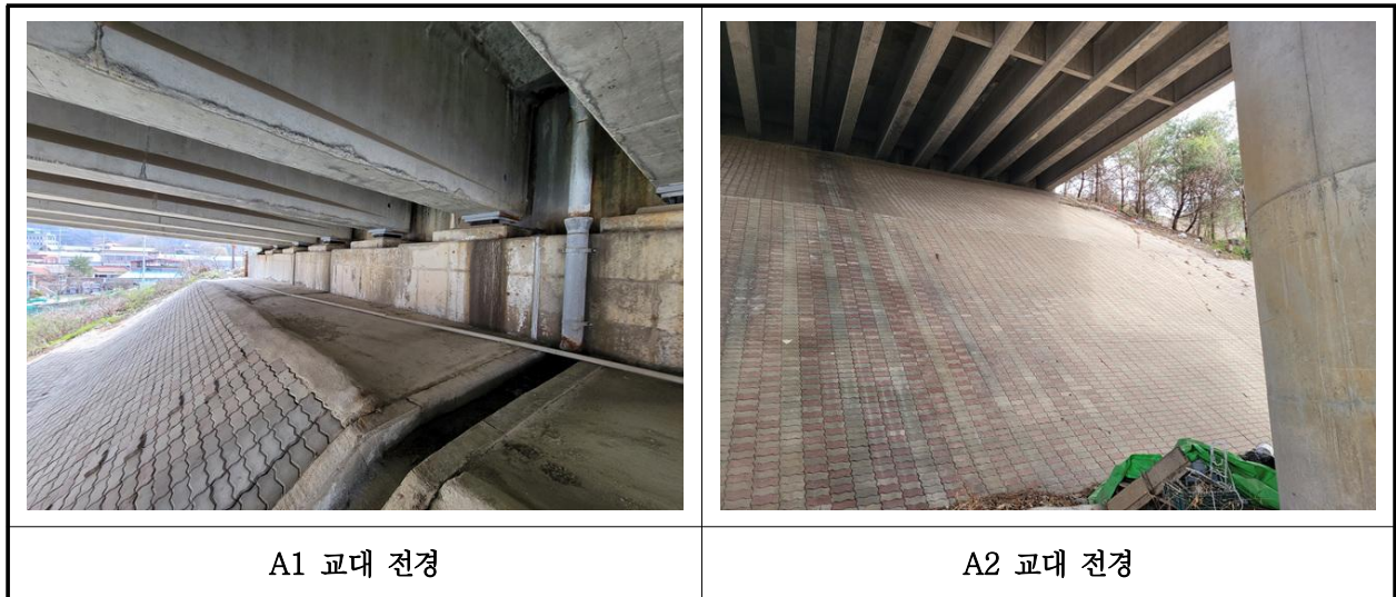
【사진 1.3.8】 교대 전경
