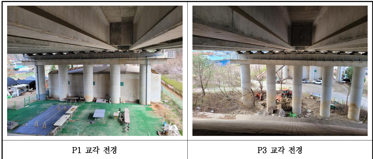
【사진 1.3.10】 교각 전경
