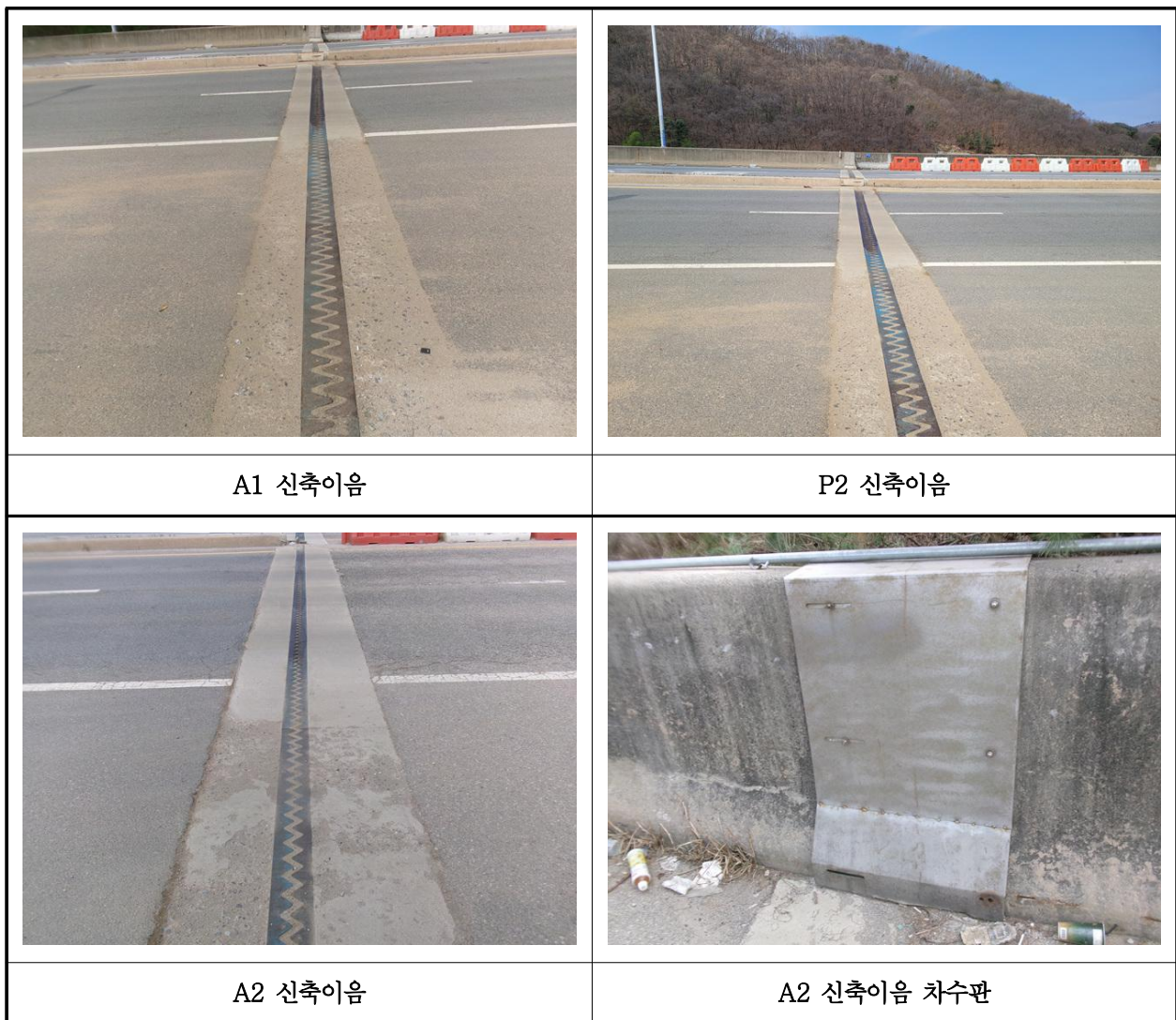
【사진 1.3.14】 신축이음장치 전경
