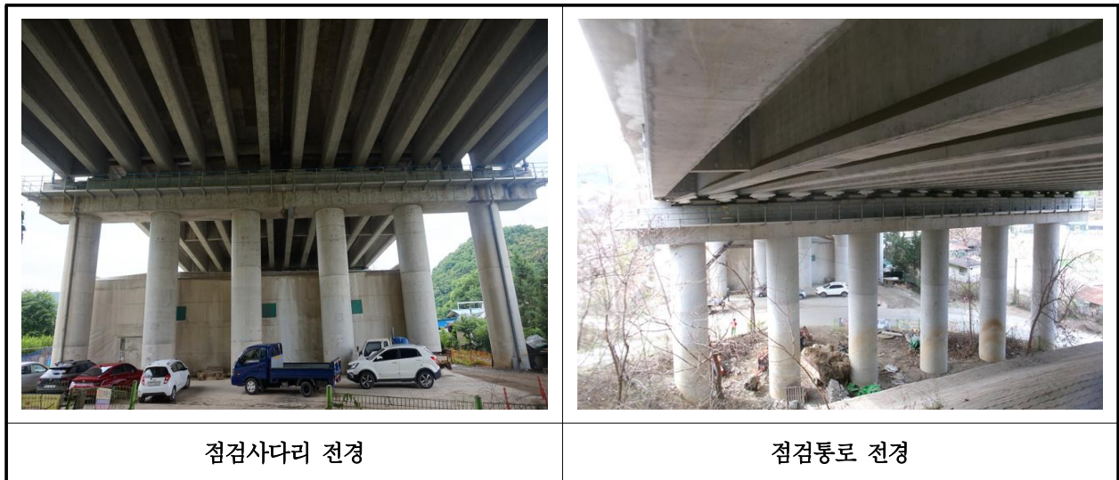
【사진 1.3.23】 교량 점검시설 전경
