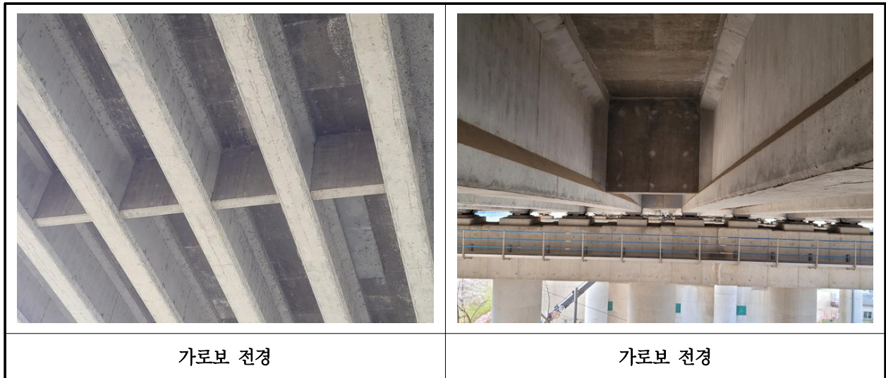
【사진 1.3.6】 가로보 전경
