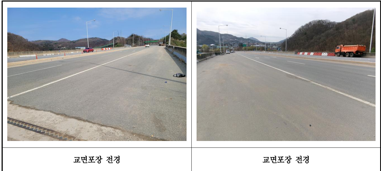
【사진 1.3.17】 교면포장 전경
